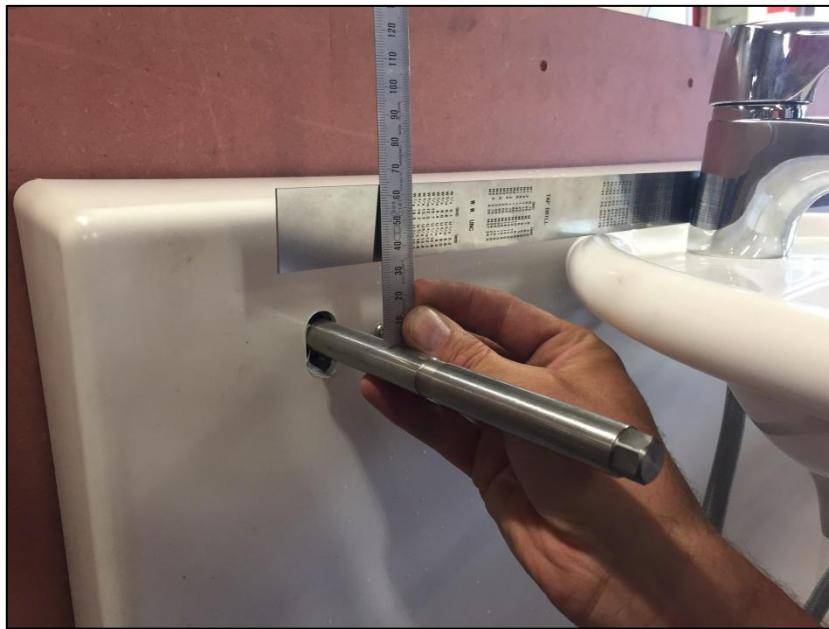
Das Waschbecken gegen die äußere Abdeckkappe drehen. Wenn möglich, eine Wasserwaage auf das Waschbecken legen. Zur Montage der Beschläge für Dock-In, die in der korrekten Höhe zu befestigen sind, sind die Beschläge ein bisschen zu lösen und anzupassen, so dass sie etwa 33 mm zwischen Beschlägen und Wasserwaage hinterlassen. Danach die Beschläge mit einem Schraubenschlüssel sorgfältig befestigen.
